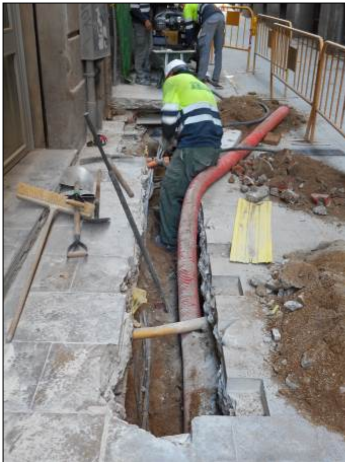
5. Inici dels treballs d'obertura de la rasa a l'alçada del nº 4, serveis.
