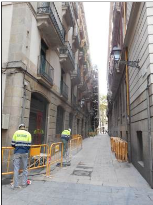
1. Inici de les tasques d'obertura de la rasa, vallat.
